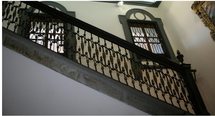
Balaustrada de la escalera
