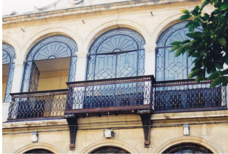
Antepecho de balcones
