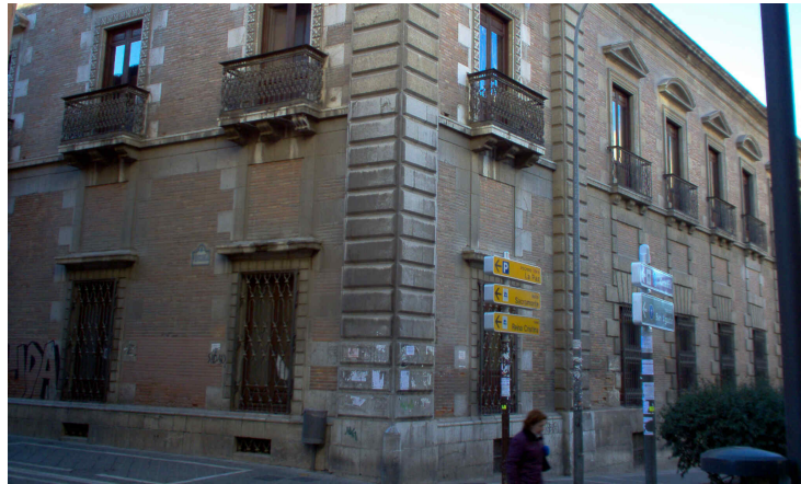
Esquina calle Puentezuelas
