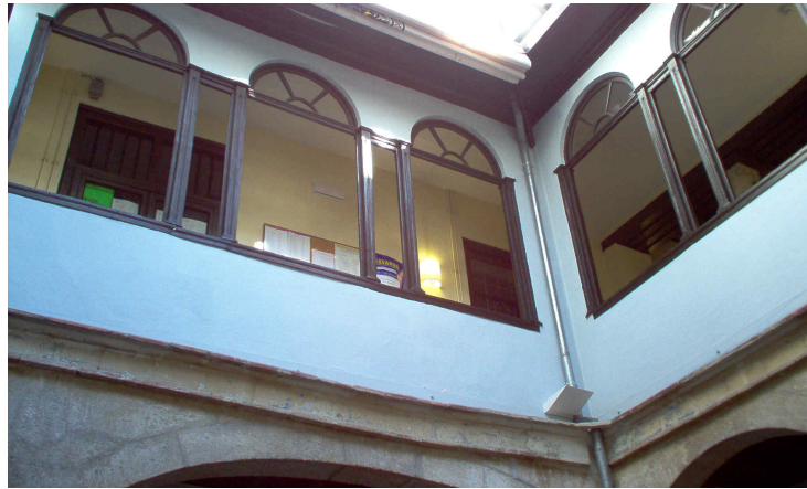
Galería primera planta
